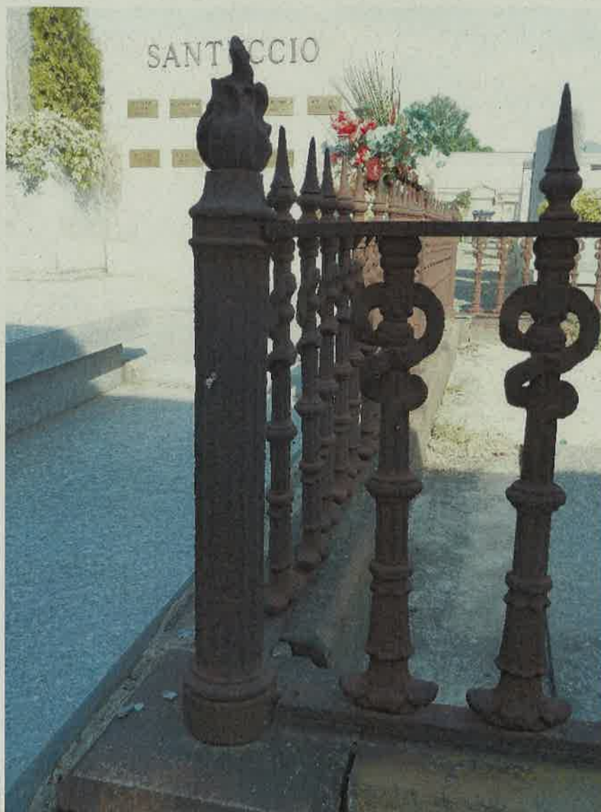
FOTO N. 4 – PARTICOLARE ANGOLARE CANCELLATA
