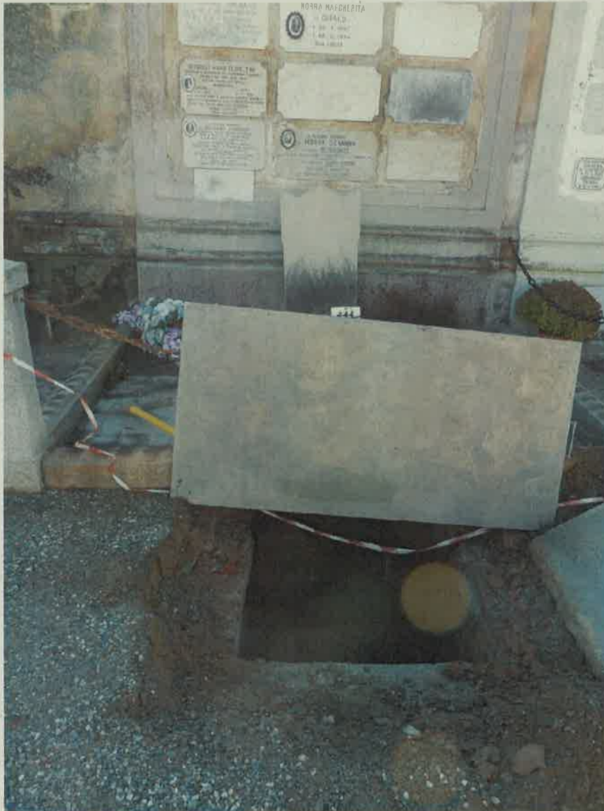
FOTO N.2 – ACCESSO A STERRO DAL VIALE (Soluzione di accesso che dovrà essere sostituita da una botola compresa nell'area della cripta)
