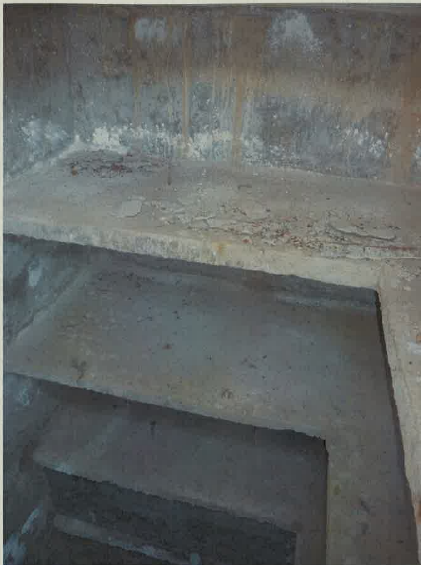
FOTO N. 3 – INTERNO CRIPTA LATO CONTRAPPOSTO
