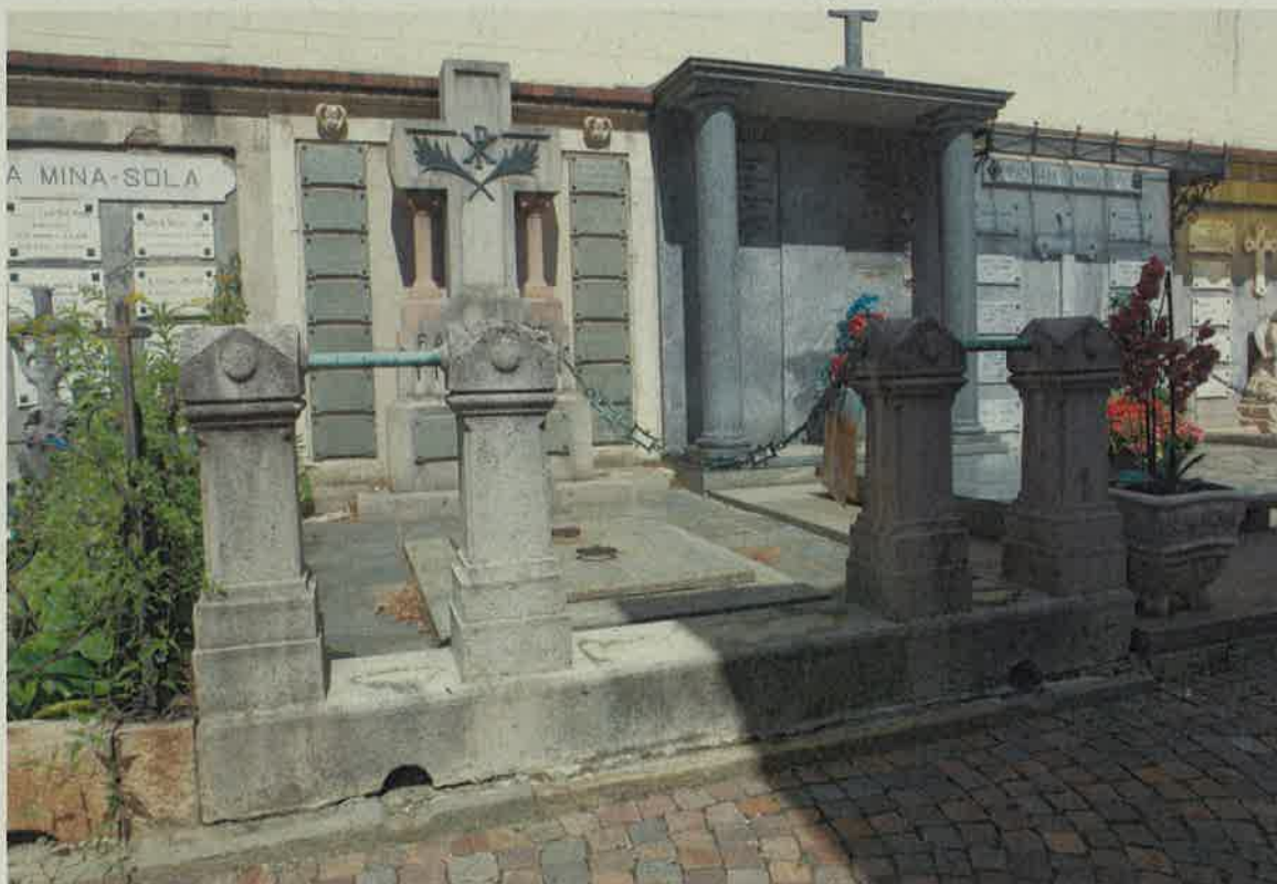
FOTO N. 1 – ESTERNO CRIPTA (Muro di sfondo: Vincolo di Soprintendenza)
