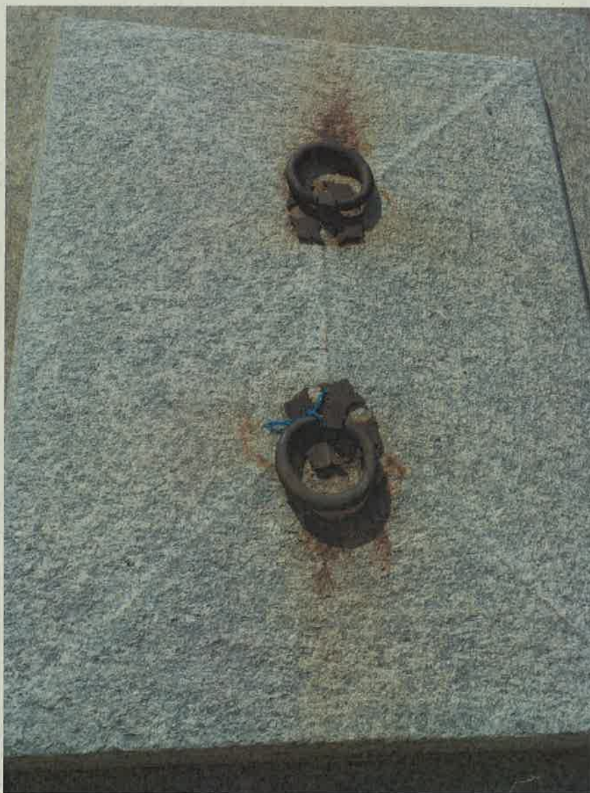
FOTO N. 2 - PARTICOLARE LASTRA COPRI BOTOLA
