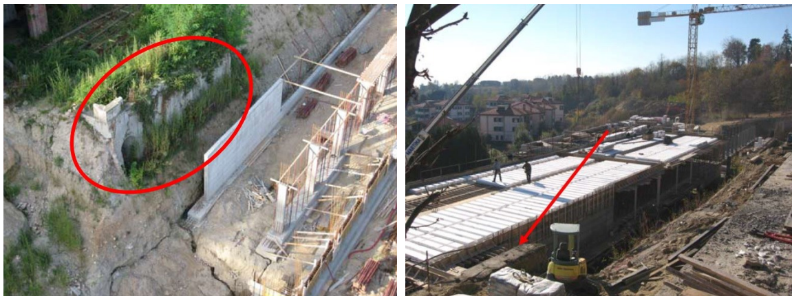
Muri di sostegno dei terrazzamenti storici ritrovati durante le operazioni di scavo
