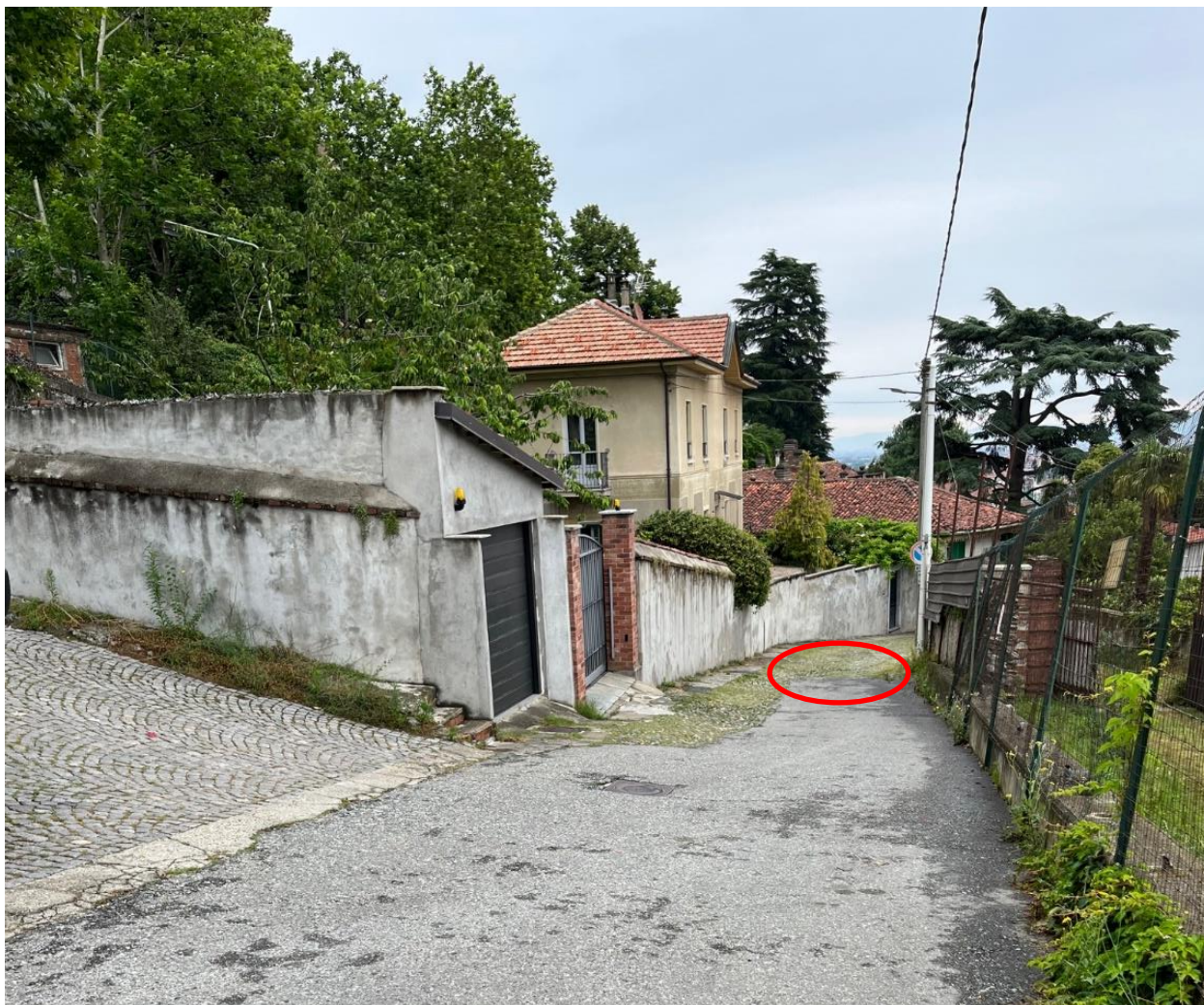
La strada di ingresso alla Palazzina Svizzera
