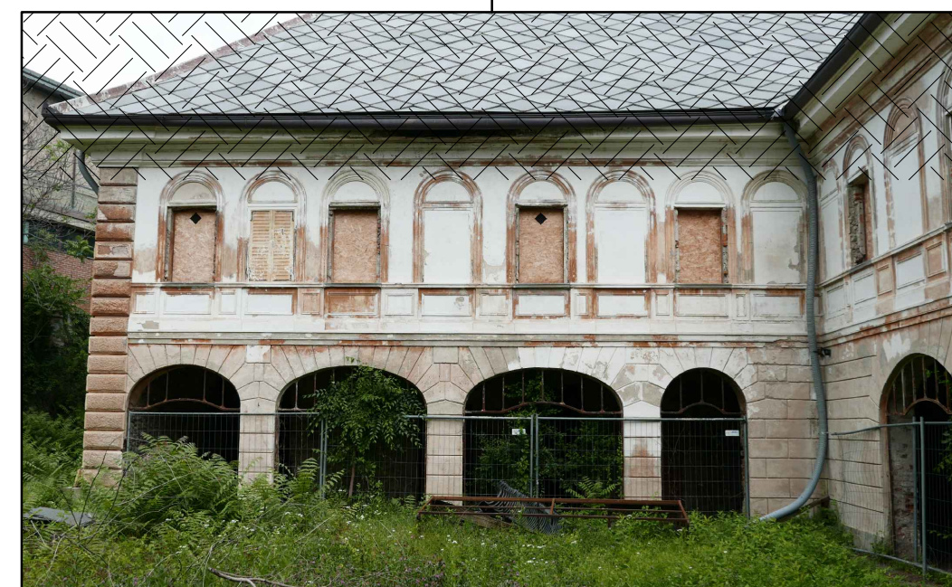
VISTA D'INSIEME PROSPETTO OVEST INT CORTILE
