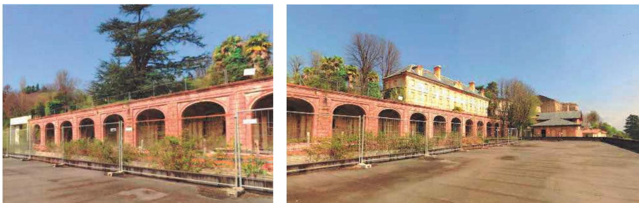
Figura 2 – Viste facciata esposta della Citroniera
