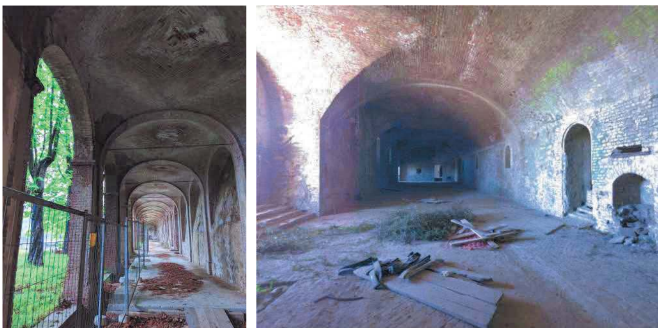
Figura 3 – Vista interna della Citroniera (sinistra) e del locale voltato posteriore (destra)
