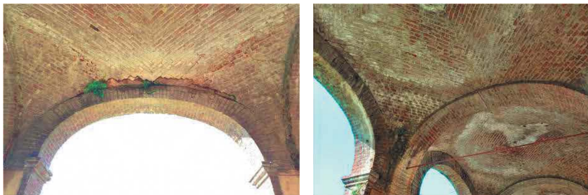
Figura 8 – Dettaglio fessure arcate Citroniera
