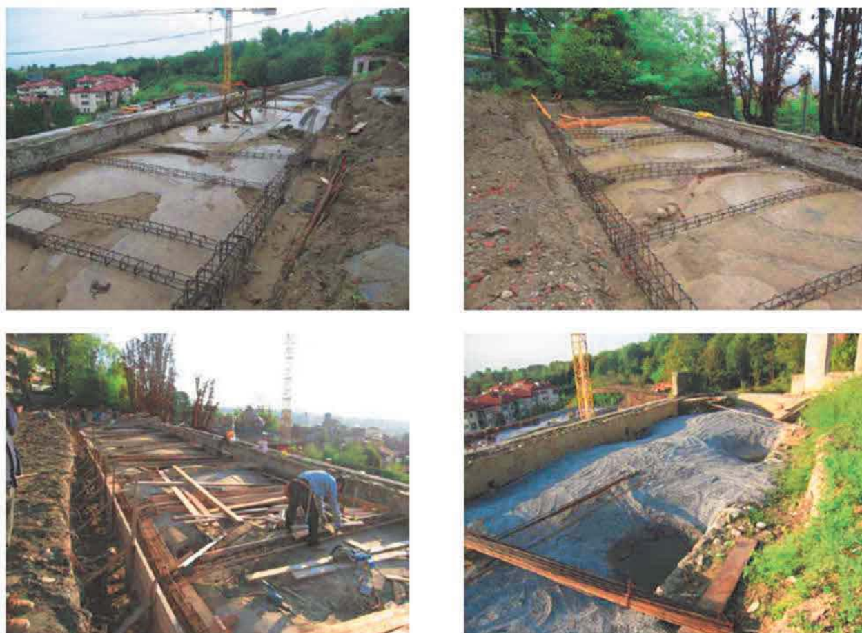
Figura 7 – Foto di archivio relative al consolidamento delle volte della Citroniera – cantiere 2011
