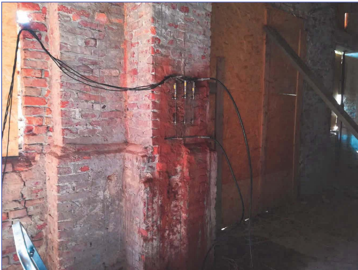
La porzione di muratura provata con il martinetto piatto doppio
