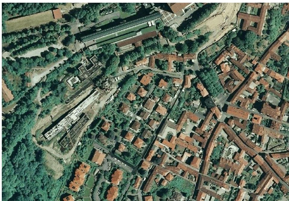
Il sito di Villa Melano durante i lavori di costruzione dei nuovi edifici. Ortofoto Geoportale Piemonte 2010 17 .
