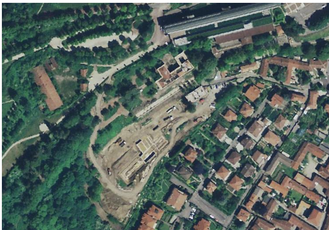
Il complesso di Villa Melano durante i lavori di costruzione dei nuovi edifici. Ortofoto maggio 2007 .
