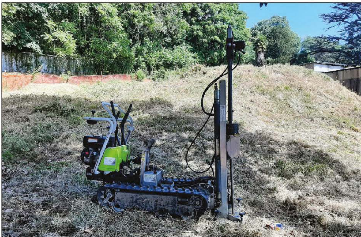
Foto 3: Prova penetrometrica dinamica P3.
