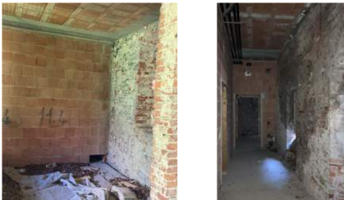
Figura 10 – Dettaglio ammassamento dei solai sulle pareti portanti
