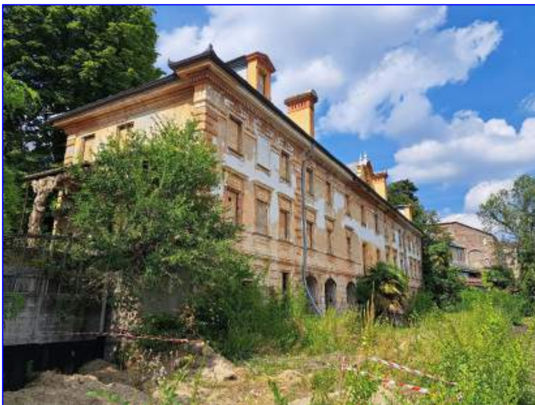
Vista dell'edificio principale (Villa Antica)
