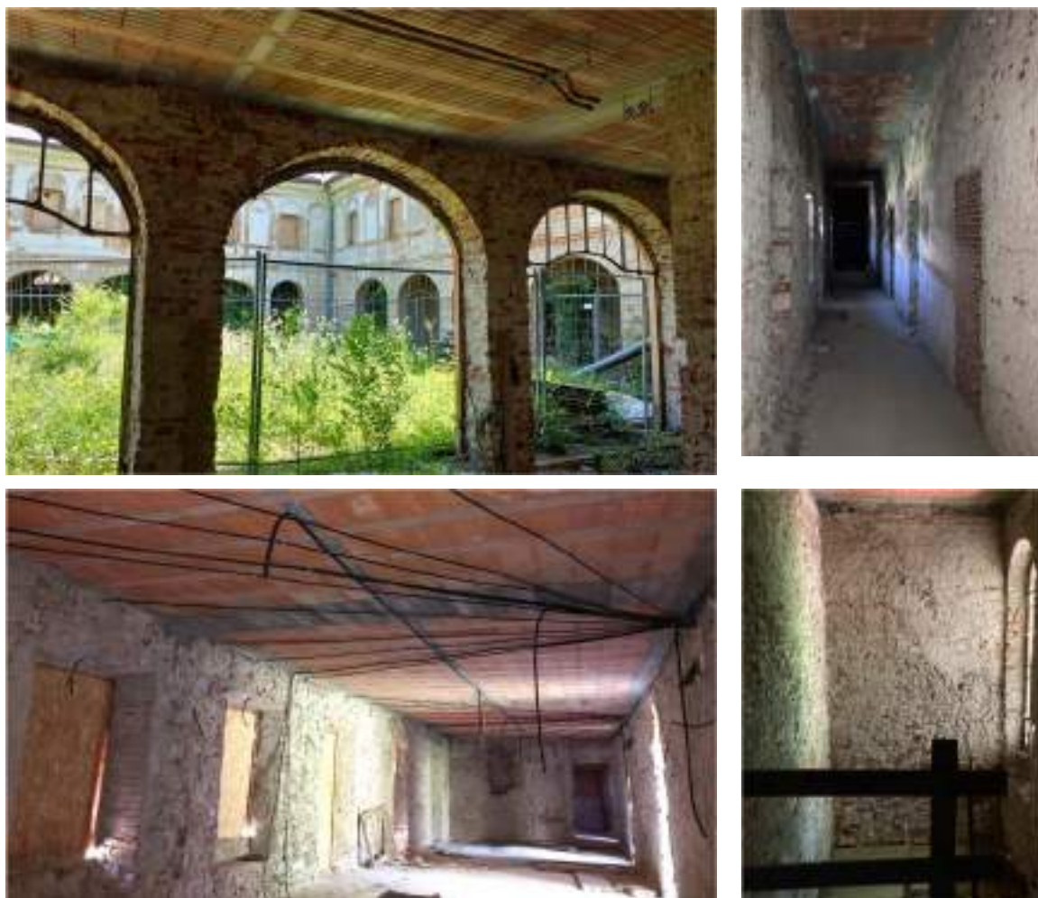
Figura 6 – Interni di Villa Antica – Buona qualità e stato di conservazione delle murature
