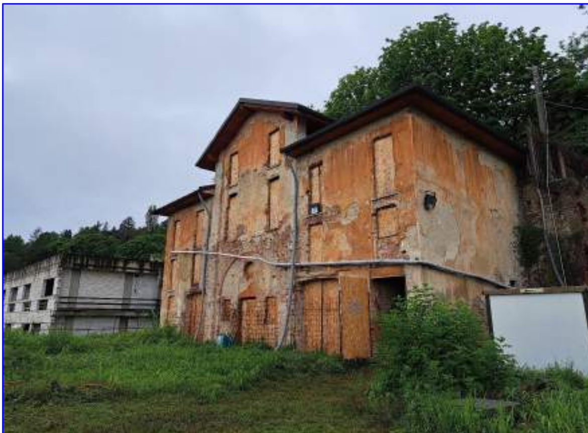
Vista del fabbricato denominato "Villino Svizzero"
