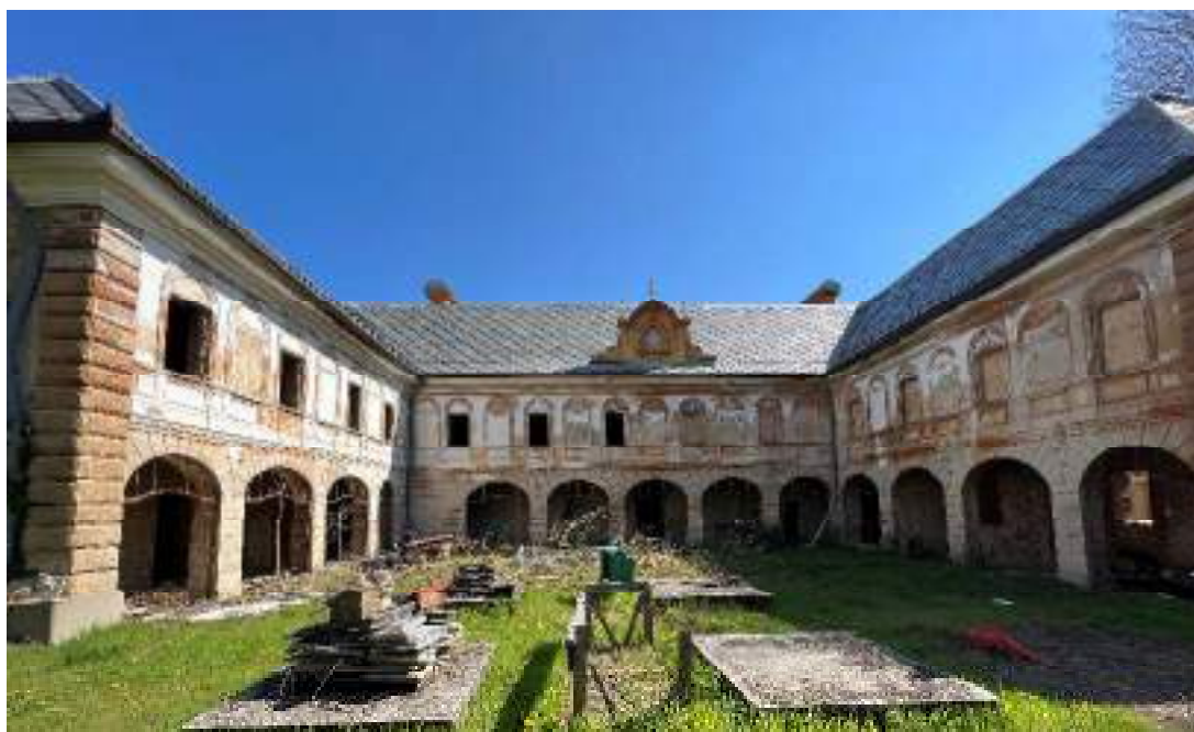
Figura 3 – Facciata Nord della Villa Antica
