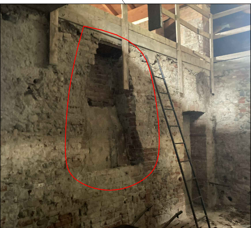
CAMINO DA CHIUDERE Intervento di ricostruzione della muratura degradata mediante cucu scuci PART. 5 m 1,27x1,50x0,20
