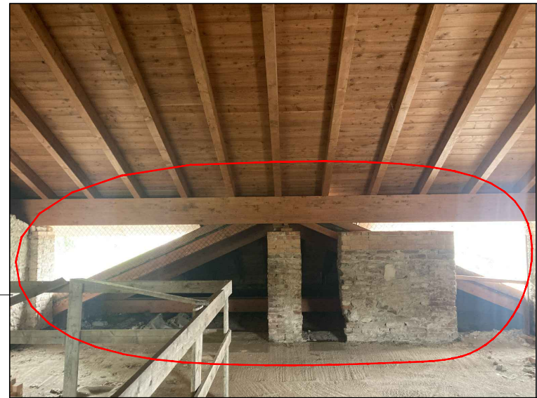
COMPLETAMENTO DELLA MURATURA DI TAMPONAMENTO Tamponamento dei vani presenti fra i maschi murari mediante intervento di ricostruzione della muratura PART. 5 m (3,41+0,63+1,14)x2,00x0,45
