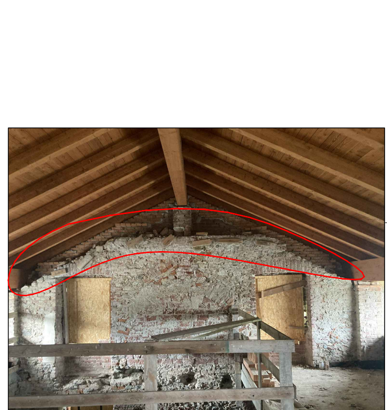
SOMMITA' MURO DA COMPLETARE Ricostruzione della muratura sino all'intradosso dei falsi puntini lignei PART. 5 m 7,56x0,30x0,4
