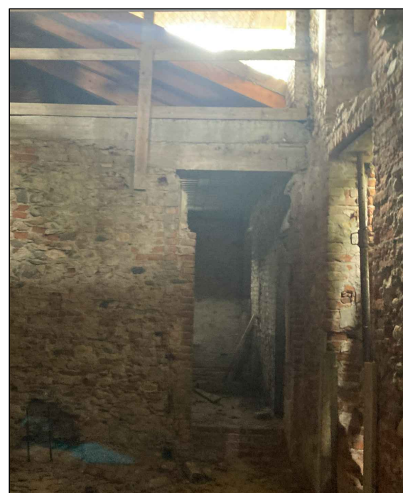
VARO PORTA DA CHIUDERE Intervento di ricostruzione della muratura degradata mediante cucu scuci PART. 5 m 0,92x2,00x0,45
