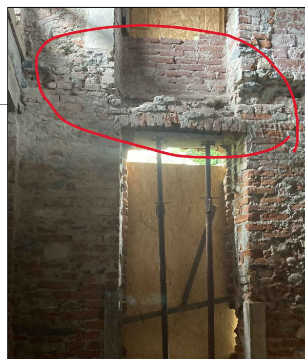
PRESENZA DI DEGRADO NEI VOLTINI E DI FESSURAZIONI IN CORRISPONDENZA DELL'APPOGGIO ALLA MURATURA Recupero dei voltini mediante sigillatura delle fessure e ripristino dell'appoggio alla muratura con eventuale intervento cucu scuci PART. 4
