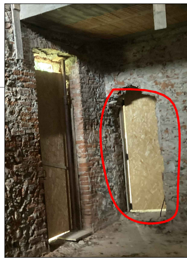
VARO DA TAMPONARE Tamponamento del vano porta mediante intervento di ricostruzione della muratura PART. 5 m 0,87x2,00x0,40
