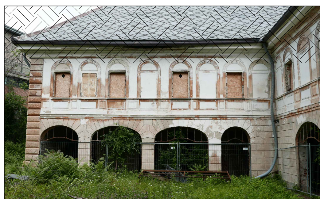
VISTA D'INSIEME PROSPETTO OVEST INT CORTILE
