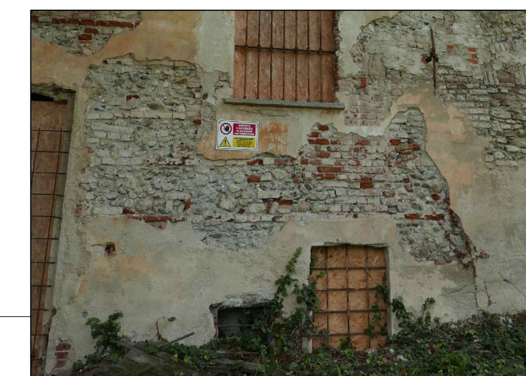
DEGRADO IN AMPIE ZONE DEL LATERIZIO E DIFFUSO SGRETOLAMENTO DELLA MALTA DI COLLEGAMENTO
