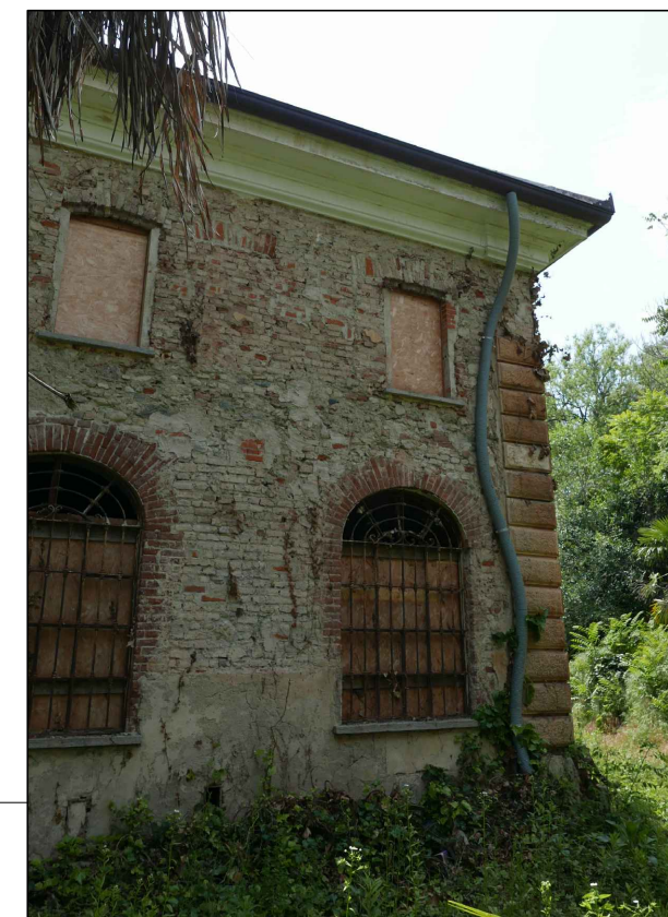
DEGRADO IN AMPIE ZONE DEL LATERIZIO E DIFFUSO SGRETOLAMENTO DELLA MALTA DI COLLEGAMENTO
