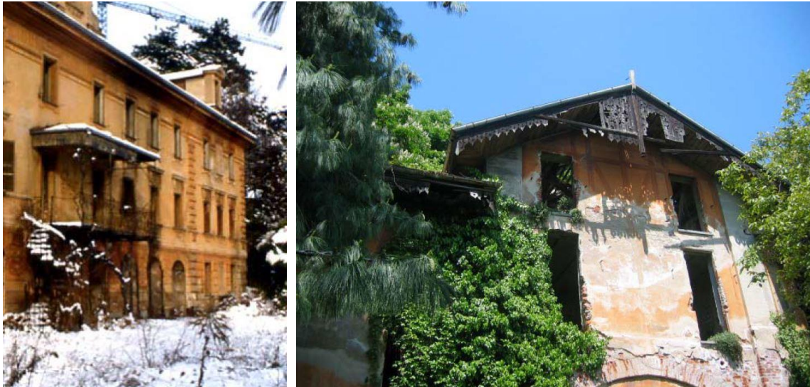
Immagini del balcone in ferro della Villa Antica e delle mantovane lignee della Palazzina Svizzera. I due manufatti, esistenti all'avvio del cantiere sono stati rimossi per il cattivo stato di conservazione e non più reinstallati
