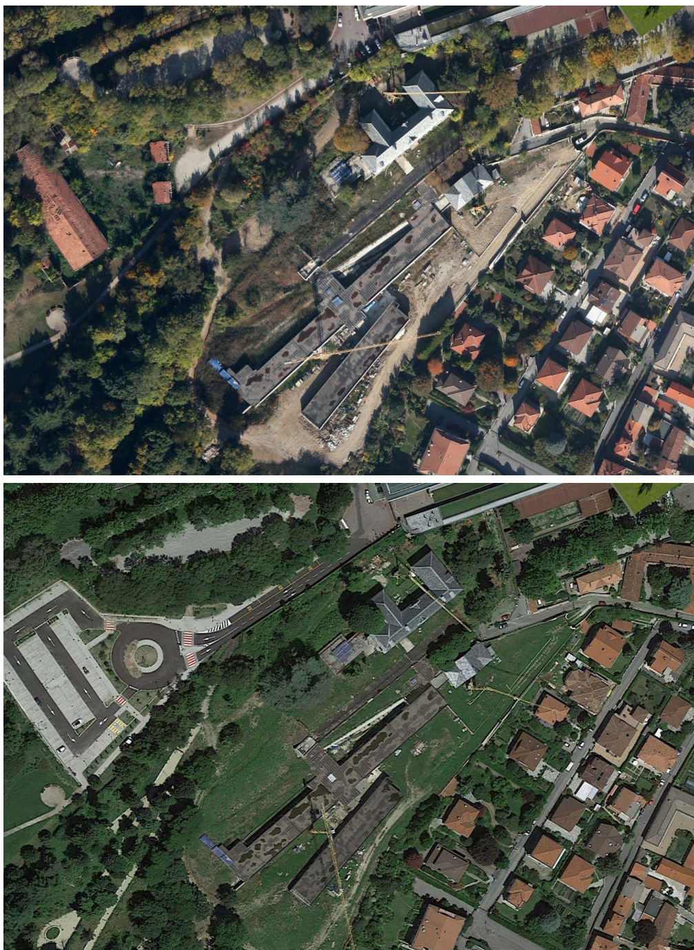
Le aree di cantiere nel 2011 (sopra) e nel 2014 (sotto)
