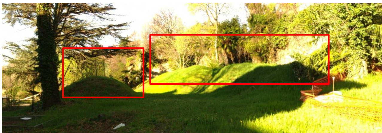
Si evidenziano i terreni di riporto nella parte nord dei giardini
