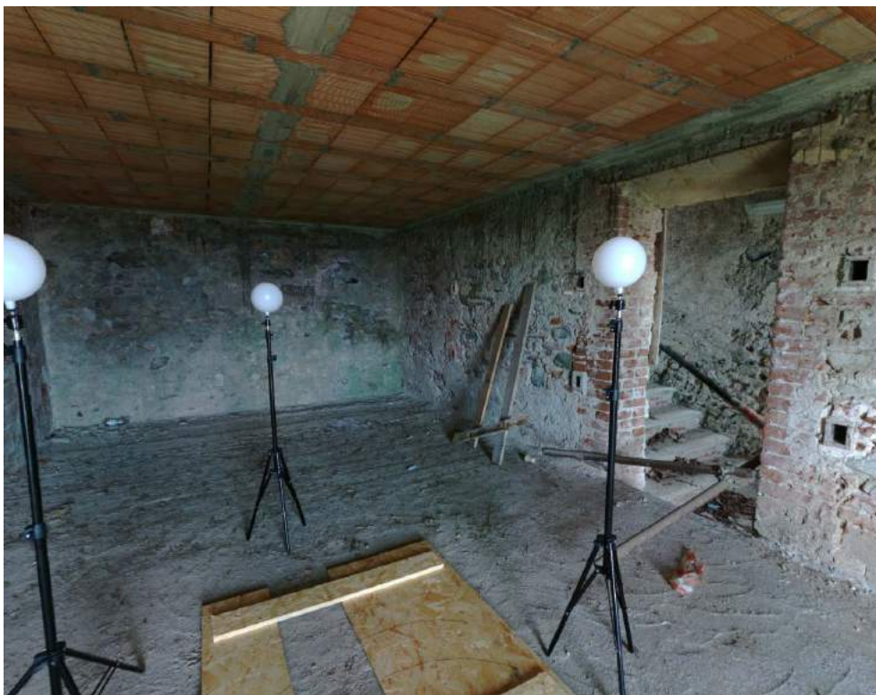
S006 - Locale mezzanino Villa Svizzera
