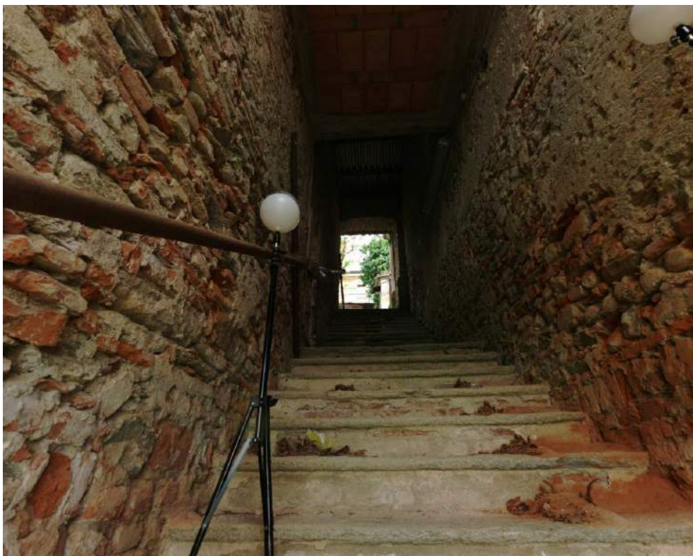
S005 - Vano scala Villa Svizzera
