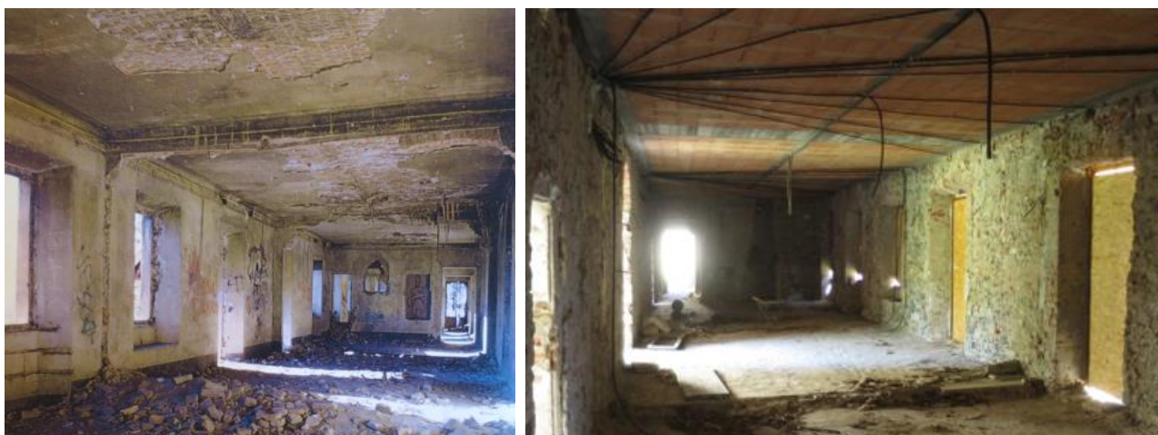
Gli ambienti interni della villa prima (a sinistra) e dopo l'intervento del 2007-2011
