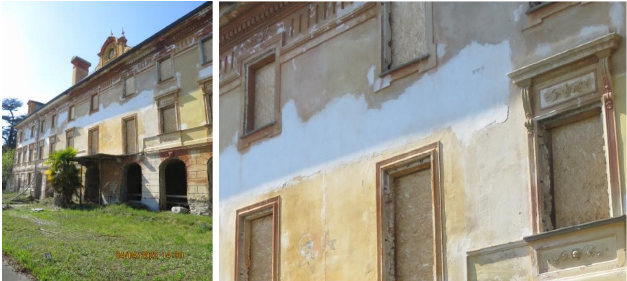
Facciata sud della Villa Antica allo stato attuale con dettaglio sulle rasature eseguite durante il cantiere del 2007-2011
