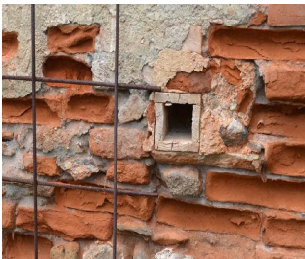
A sinistra: interni della Palazzina Svizzera; a destra: le canne lignee inserite all'interno delle murature perimetrali
