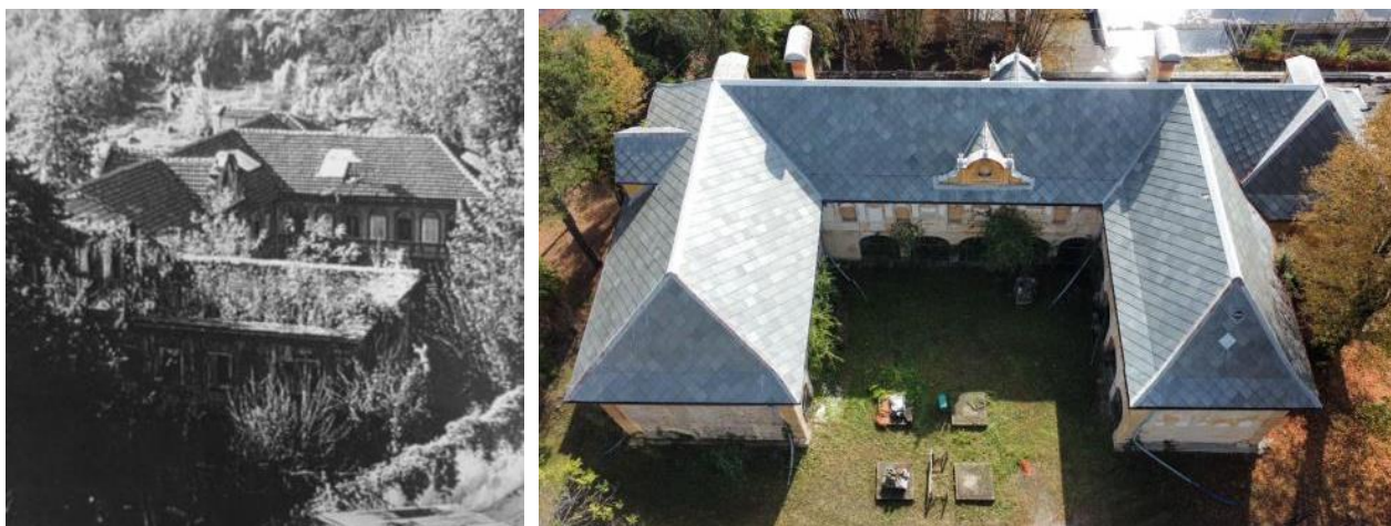
Le coperture prima e dopo l'intervento di rifacimento
