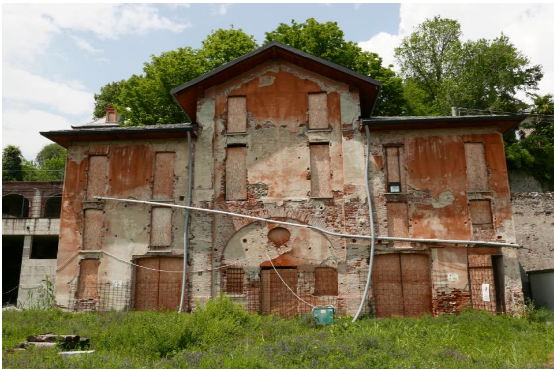
Facciata meridionale della Palazzina Svizzera nello stato attuale
