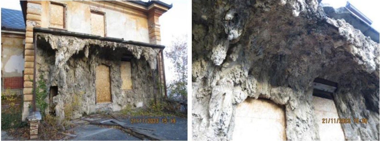
Foto del grottino allo stato di fatto
