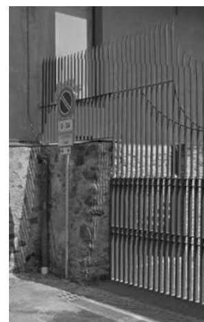
Cancellata che affaccia su Via della Cava del Castello di Rivoli
