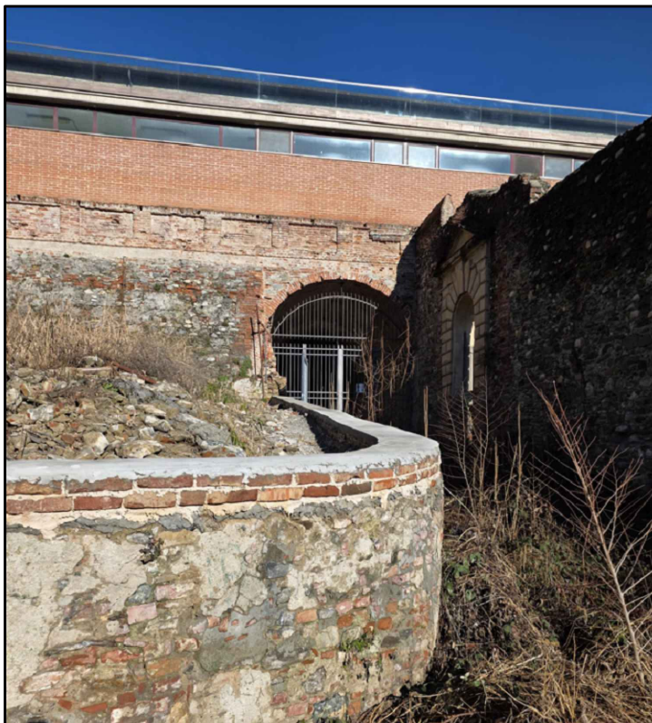
MURATURA DI CONFINO SU VIA MELANO
