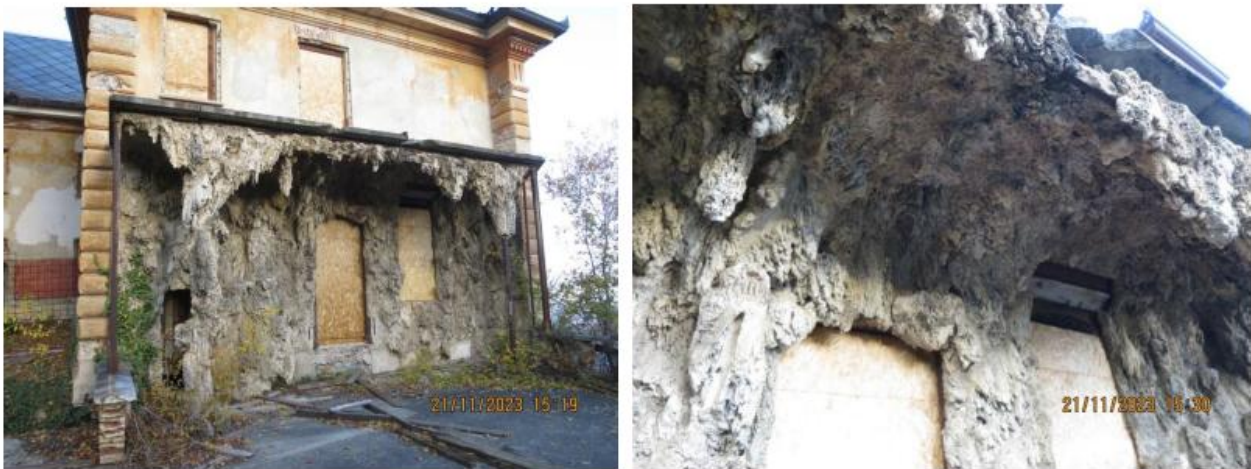
Foto del grottino allo stato di fatto
